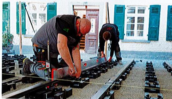
**Praktisch: Die Vario Fix-Unterkonstruktion ist stufenlos höhenverstellbar und gleicht mit ihrem 360°-Kugelkopf einen unebenen Untergrund aus.**
