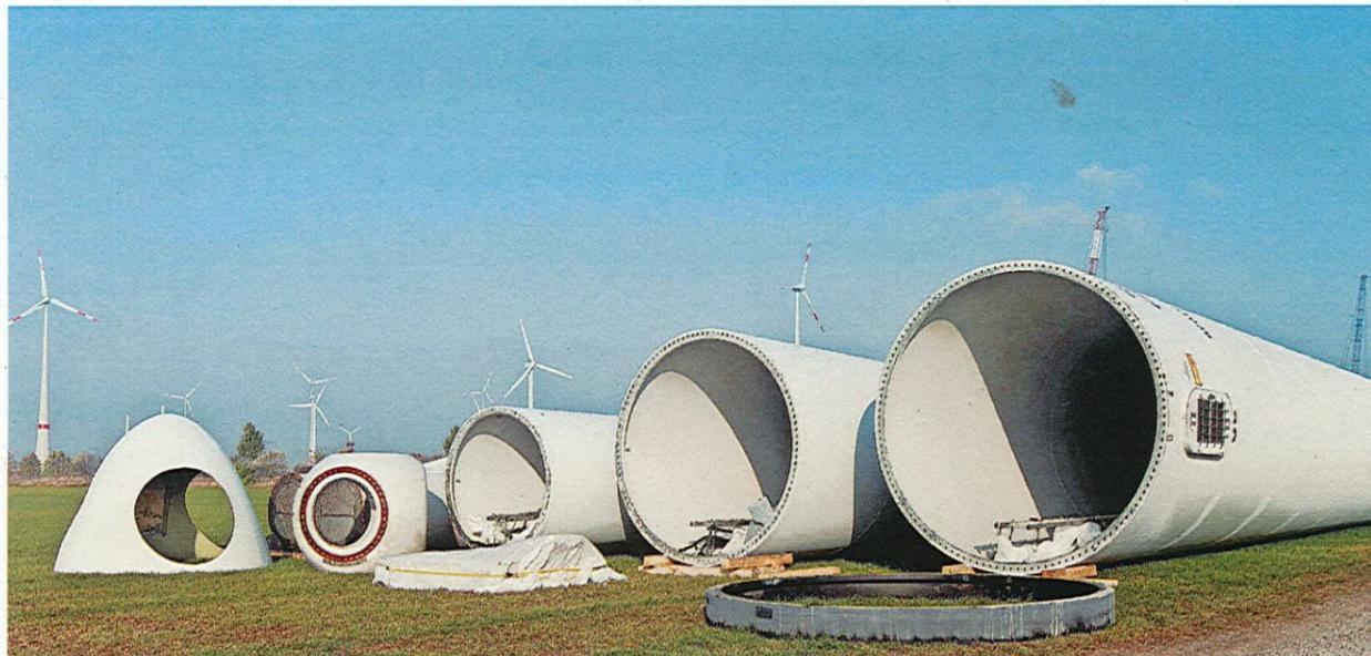
Was passiert mit den Altanlagen? Teile eines demontierten Windrades liegen auf einem Feld im Salzkammergut. Foto: dpa
